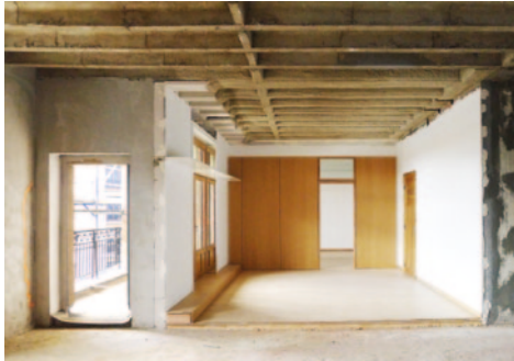
Fig. 13 | 01-494 | Gebouw C van de Résidence Palace (Raad van de Europese Unie) | Brussel | 2005-2015
